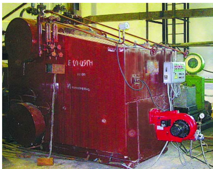
Испытательная лаборатория БиКЗ Котел E 1-0,9 с дизельной горелкой L5Z исполнения SF
