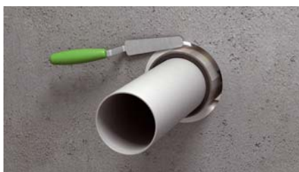
5. Заполните зазор пеной или строительным раствором
